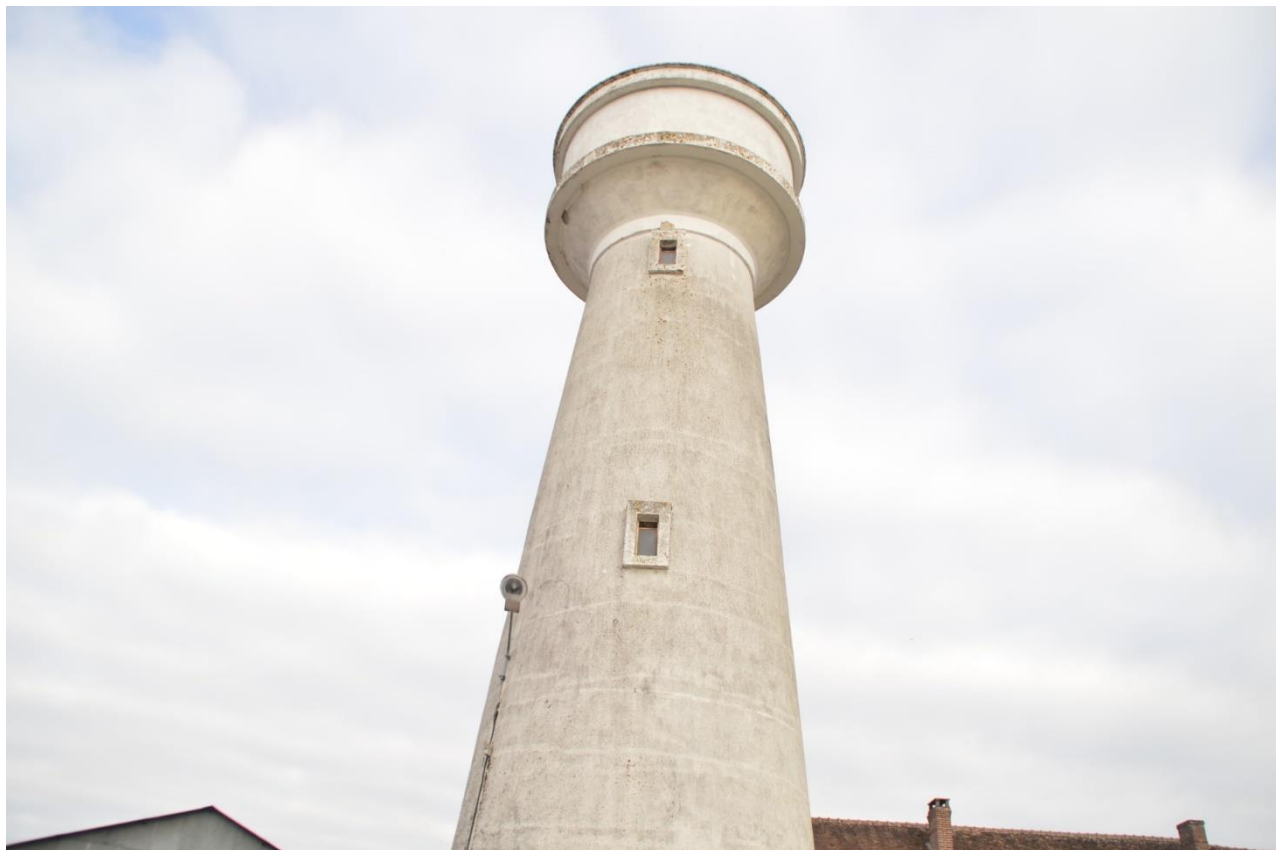
Figure 2 : Le château d'eau de Beaudemont
