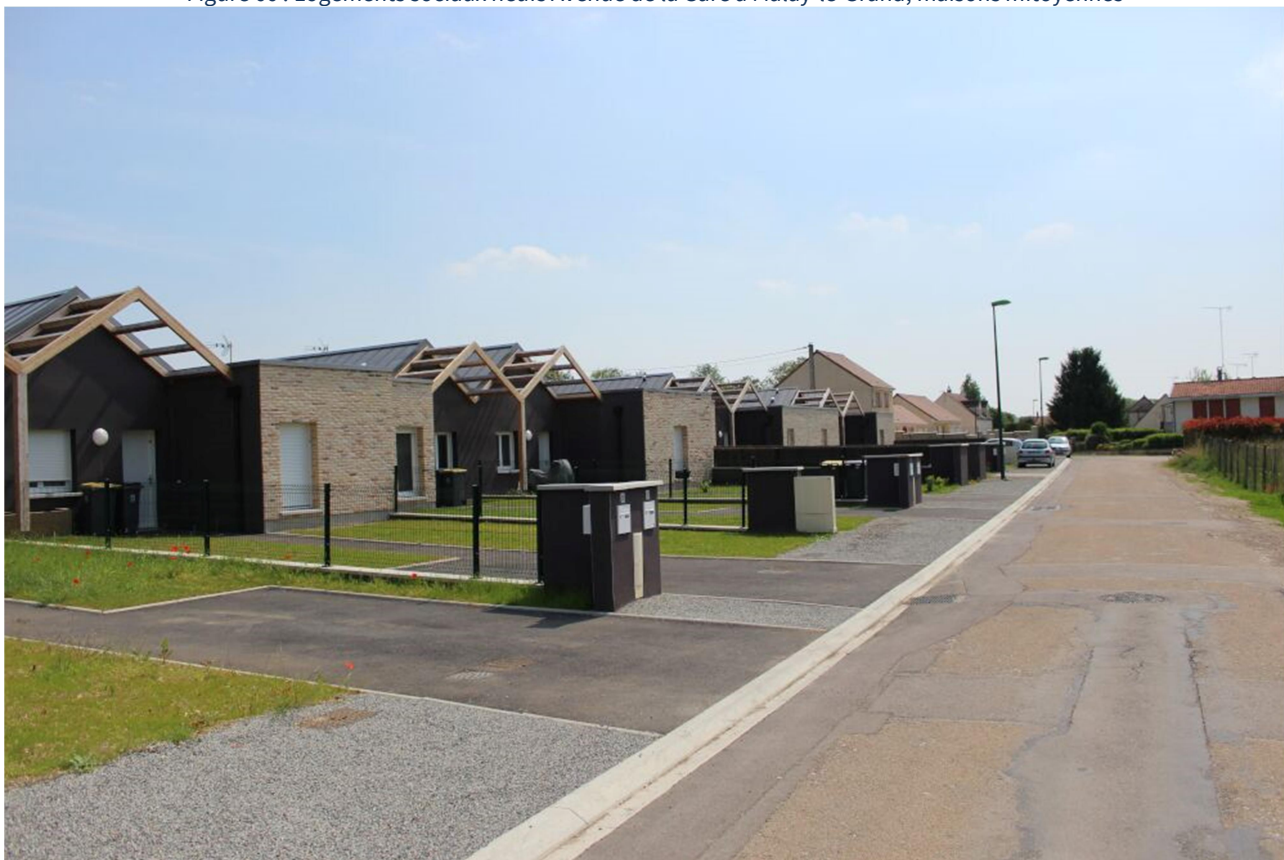
Figure 66 : Logements sociaux neufs Avenue de la Gare à Malay-le-Grand, maisons mitoyennes
