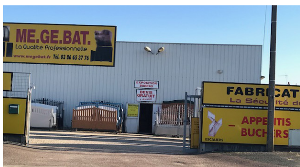
Saint-Denis-lès-Sens : des enseignes trop nombreuses, surdimensionnées, mal implantées et peu qualitatives.
